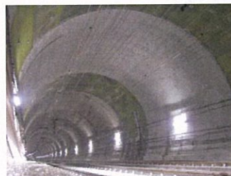
トンネル覆工の補強
