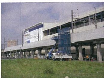
駅舎部高欄補修
