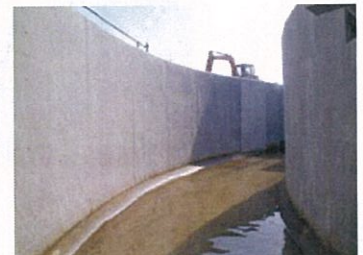
農業用水路壁面補修
