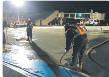
半たわみ舗装
