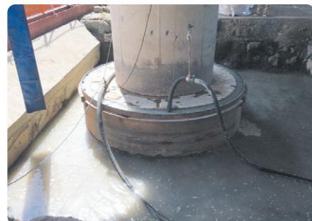
水中橋脚補強工事
