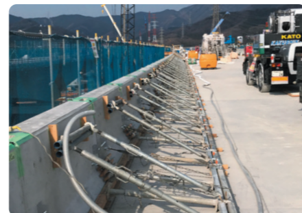
Pca高欄設置工事
