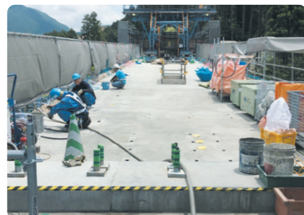
PC床版設置工事
