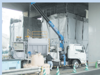
耐震補強工事(橋脚)
