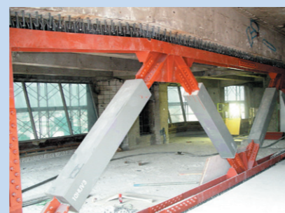
耐震補強工事(建築)
