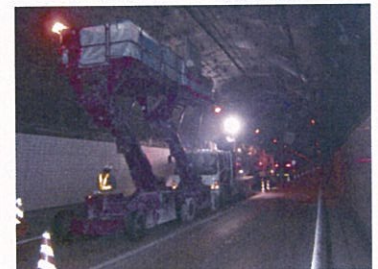
道路トンネル (ミキサー車にて搬入)
