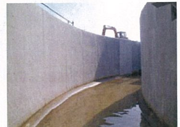
農業用水路壁面補修
