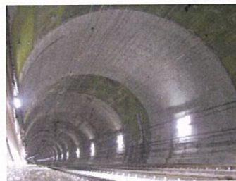
トンネル覆工の補強
