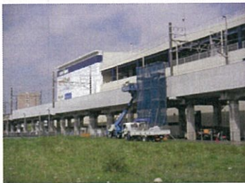
駅舎部高欄補修
