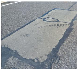
橋梁の補修跡(再劣化)
