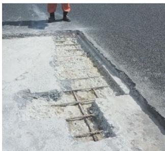
繰り返し荷重による床版上面の損傷
