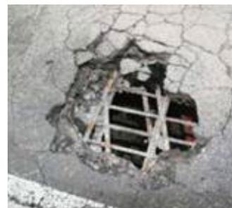
床版の疲労による部分抜け落ち
