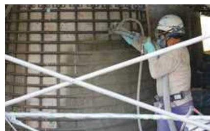
橋脚鉄筋増設工事
