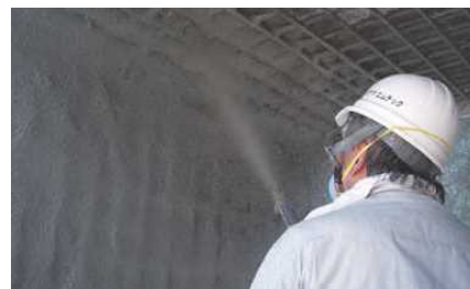
床版補強工事
