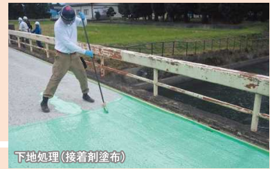
下地処理(接着剤塗布)
