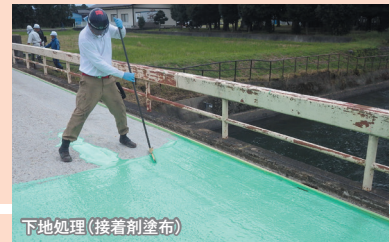
下地処理(接着剤塗布)
