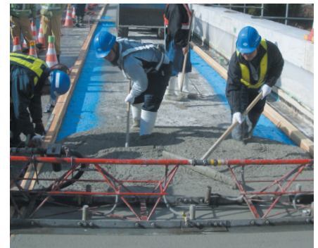
簡易フィニッシャーによる仕上げ
