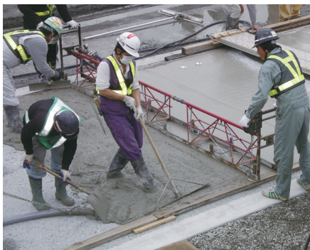
ポンプ圧送による流し込み
