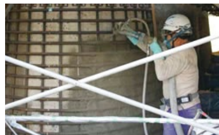
橋脚鉄筋増設工事
