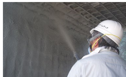
床版補強工事
