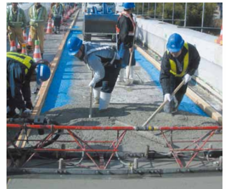
簡易フィニッシャーによる仕上げ
