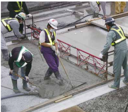
ポンプ圧送による流し込み
