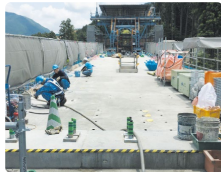
PC床版設置工事
