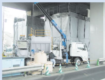
耐震補強工事(橋脚)
