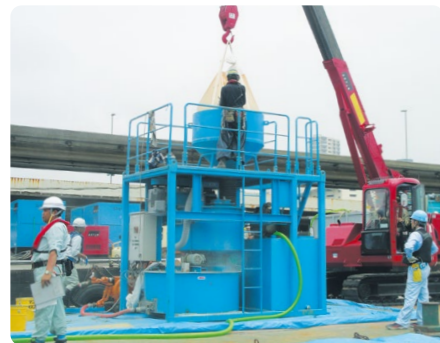
水中橋脚補強工事
