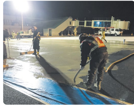
半たわみ舗装
