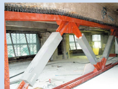
耐震補強工事(建築)
