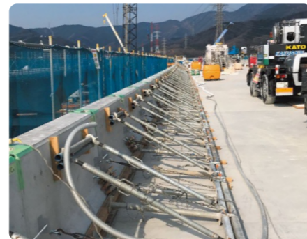
Pca高欄設置工事
