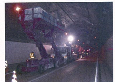
道路トンネル (ミキサー車にて搬入)
