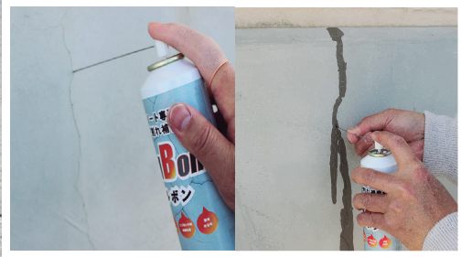
ゲルボンをひび割れに注入
